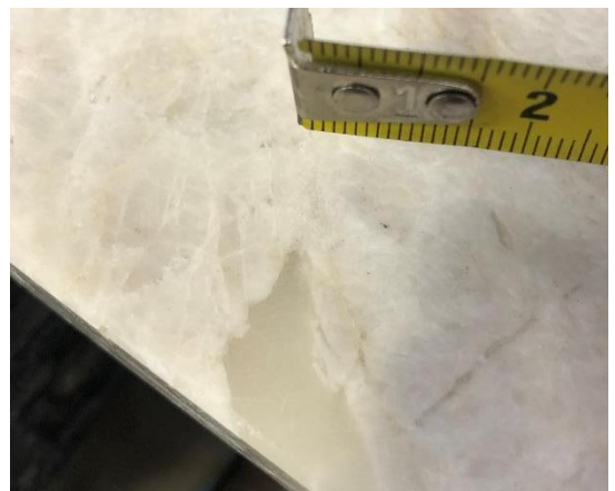
Den matta, enhetliga fläcken är en spackling utförd med resin.
