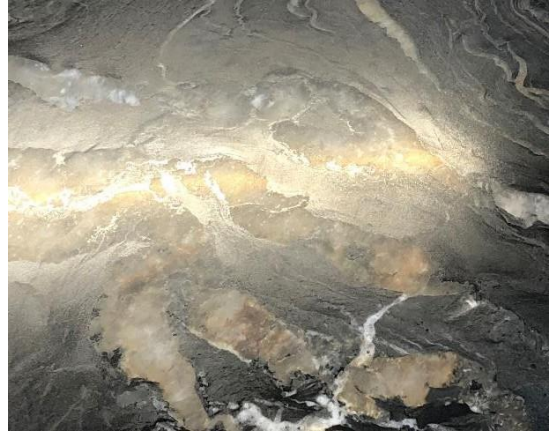
Här ses skillnad i reflektion som följer av varierande mineralsammansättning. Skillnaden kan både ses och kännas.
