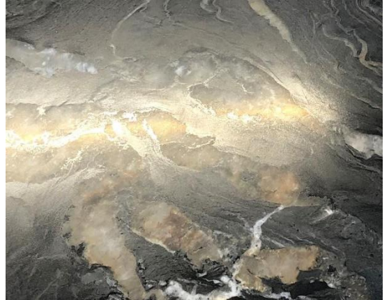
Her ses forskjell i refleksjon som følge av varierende mineralsammensetning. Forskjellen kan både ses og kjennes.
