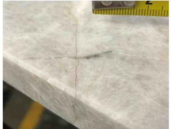
Her ses en mindre glassåre, som visuelt kan forveksles med en sprekk.
