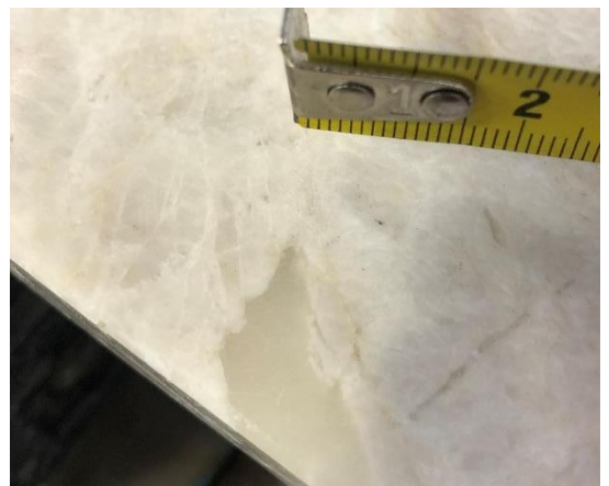
Den matte, ensartede flekken er en utsparkling utført med resin.
