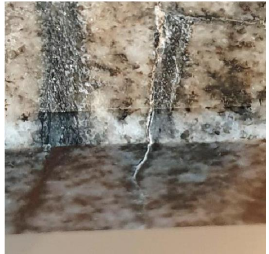
Close-up af en forkant og undersiden af pladen med gennemgående revne og synligt mellemrum mellem brudfladerne.
