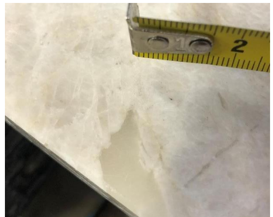
Den matte, ensartede plet er en udspartling udført med resin.
