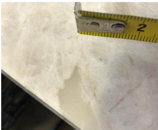
Det matta enfärgade fältet är en utfyllnad med harts
