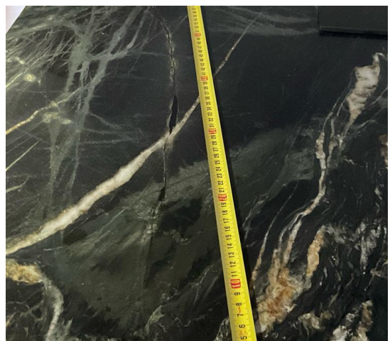
Det matte sorte felt er en udspartling af en glasåre med mørk resin.
