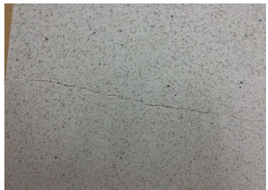
Exempel på en spricka
