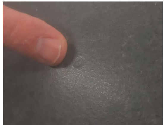
Eksempel på en fordypning som må aksepteres
